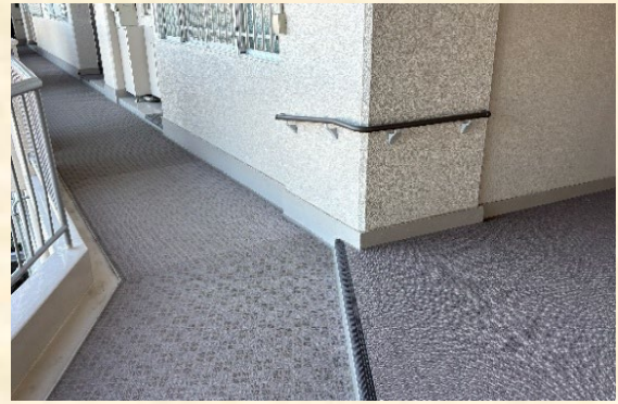
EV ホール出入口補助手すり設置 施工完了
