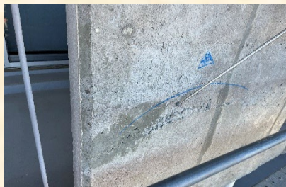
塗膜剥離後マーキング調査
