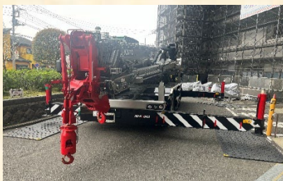
【レッカー車両 搬入・誘導
