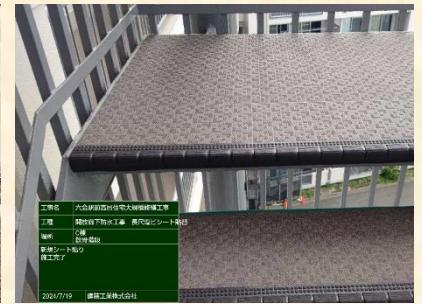
鉄骨階段 施工状況
