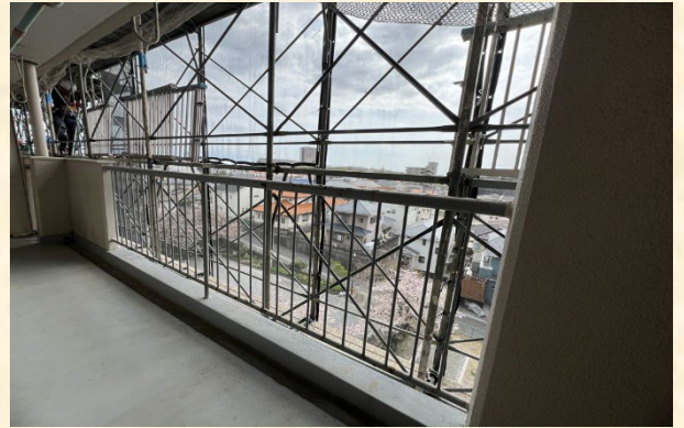
バルコニー手すり 施工前
