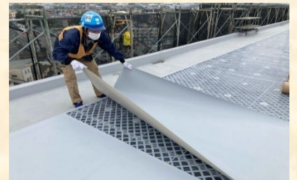
仕上げシート敷き込み
