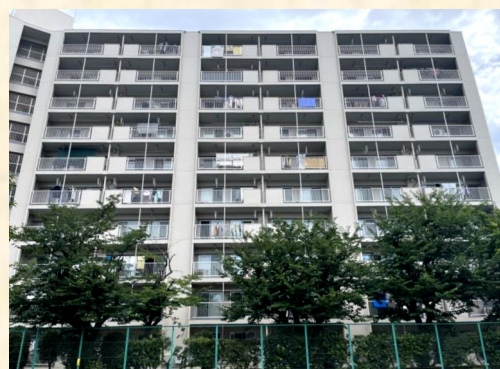
バルコニー側 施工完了②
