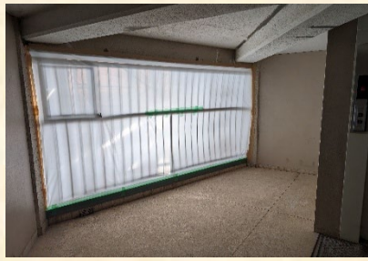
E Vホール 隔離ビニル養生
