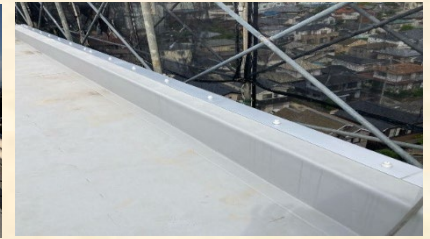
大庇シート 施工完了
