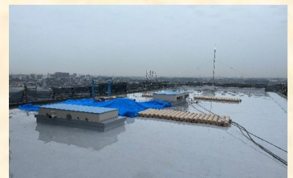
資材仮置き 風散養生実施
