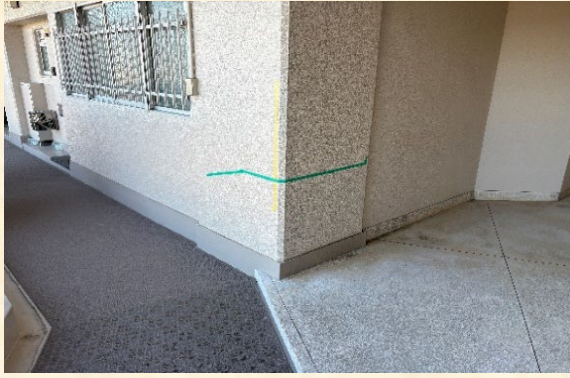
EV ホール出入口補助手すり設置 施工前
