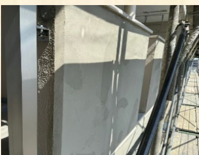
外壁塗装 施工前
