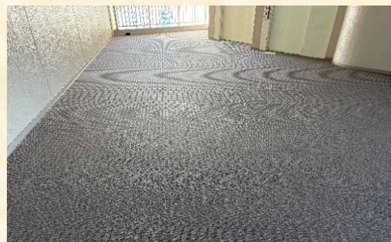
EV ホール床シート張り付け 施工完了
