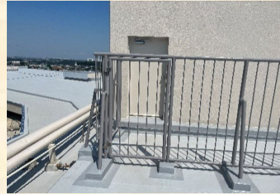
施工完了 扉復旧完了
