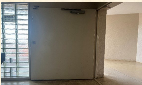
階段室鉄扉更新 施工前
