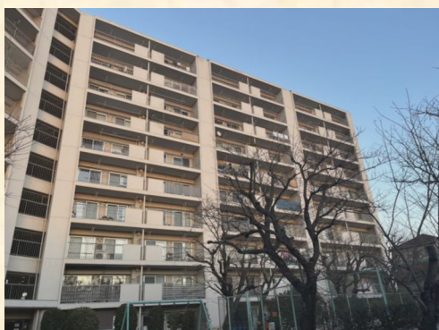
バルコニー側 施工前②
