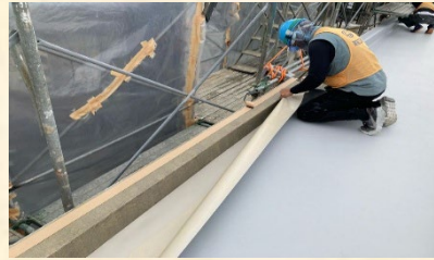
大庇シート張り付け
