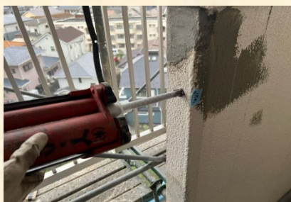
アンカー用樹脂注入
