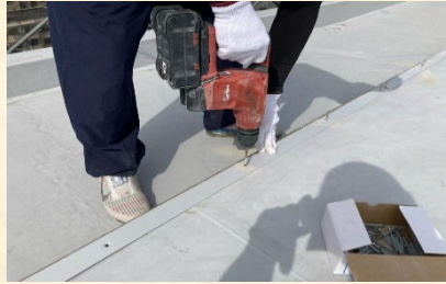
平場シート端部プレート固定
