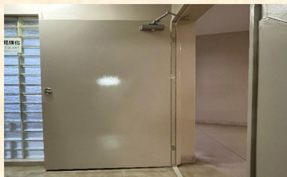
階段室鉄扉更新 施工完了
