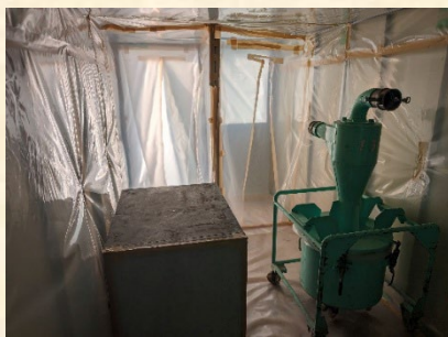
回収装置室 隔離養生状況
