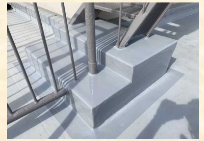
笠木・階段 施工完了
