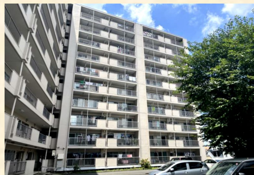
バルコニー側 施工完了①
