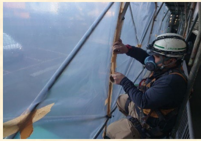
足場上 隔離ビニル養生
