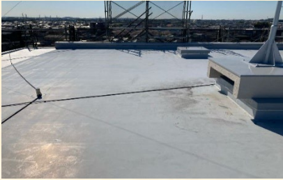
屋上防水 施工前
