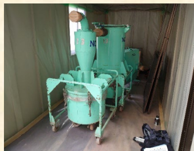
集塵剥離機 設置状況
