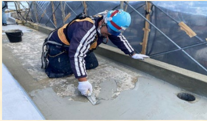
大庇シート撤去後、仮防水
