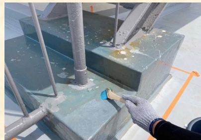
ウレタン部分プライマー塗布
