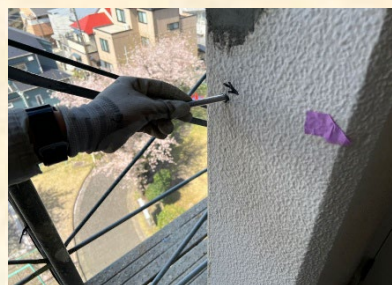
ケミカルアンカー設置中
