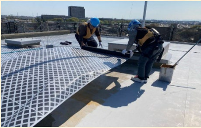
ボンド塗布、マット敷き込み
