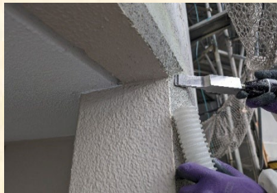
壁面取合部など塗膜除去作業
