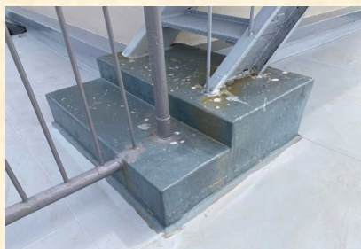
ウレタン笠木・階段 施工前
