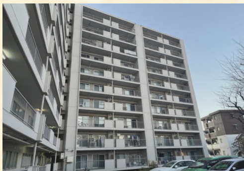
バルコニー側 施工前①
