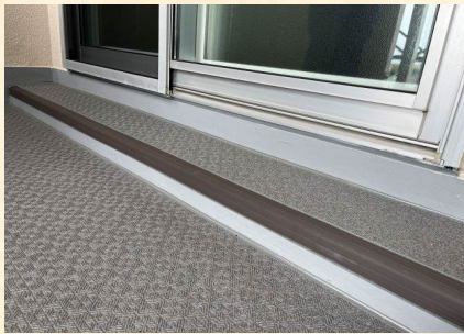
バルコニー面台 施工状況
