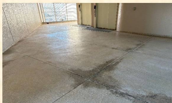
EV ホール床シート張り付け 施工前
