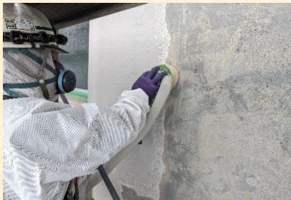
外壁既存塗膜除去作業
