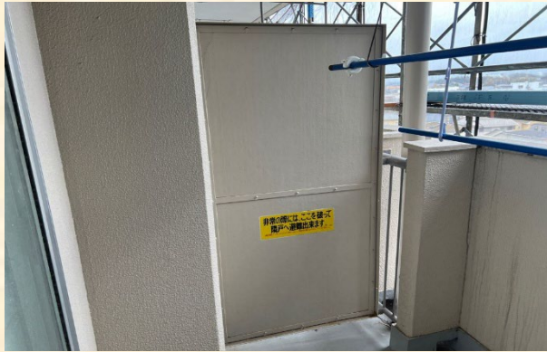
バルコニー間隔て板 施工前
