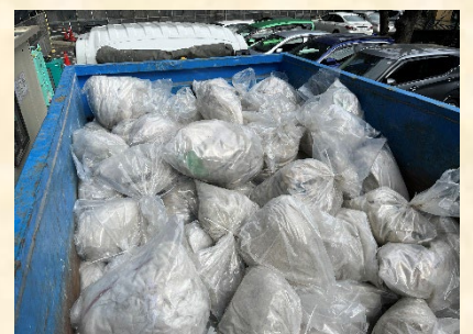
石綿含有廃棄物 搬出状況
