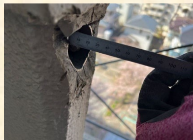
手すり撤去深さ確認
