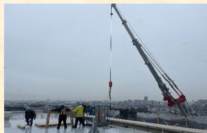
資材搬入 レッカー作業
