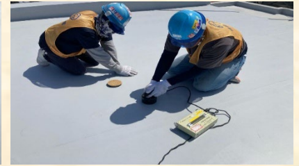
平場シート機械式溶着固定
