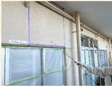
外壁塗装試験施工 施工前
