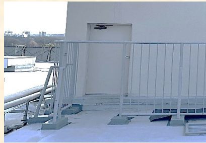
フェンス支柱架台 施工前
