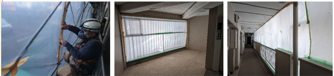
足場上 隔離ビニル養生 ← EVホール 隔離ビニル養生 ← 廊下内 隔離ビニル養生 ←
