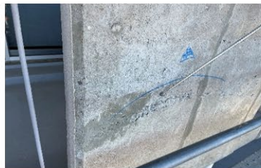
塗膜剥離後マーキング調査 ←
