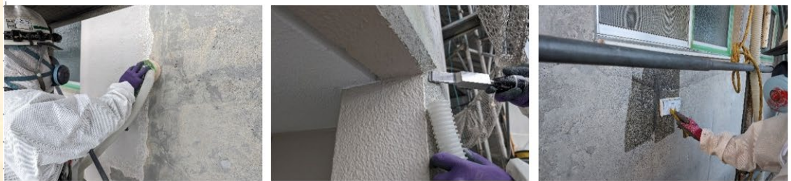
外壁既存塗膜除去作業 ←
