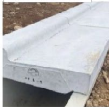
既設L型側溝参考写真
