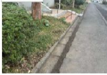
既設L型側溝参考写真
