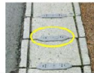
取っ手部化粧タイル 取付 (落葉対策)
