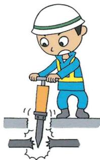
マンション敷地内で杭を打ち込んだところ、**管理組合から渡された図面に誤りがあり、地中埋設給水管を破損させてしまった。**
