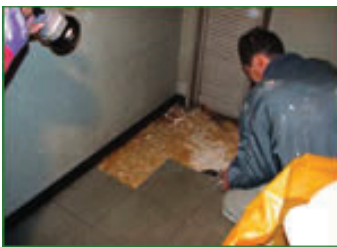
内部床のPタイル
