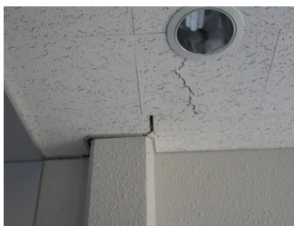
天井の吸音板
