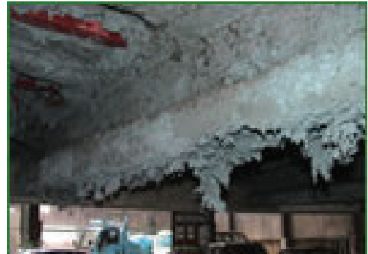
駐車場鉄骨の耐火被覆
