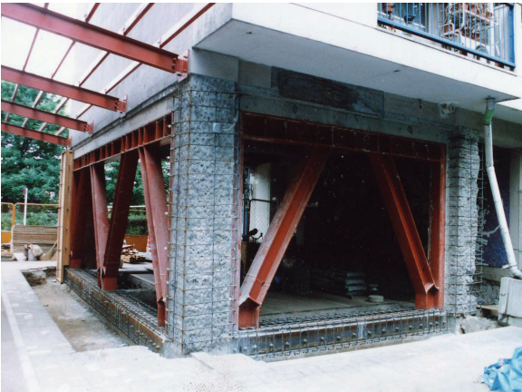
バットレス補強事例
