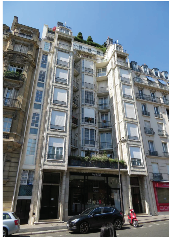
オーギュスト・ペレの1903年の世界最古といわれるRC造集合住宅
