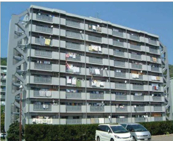
バットレス補強事例
