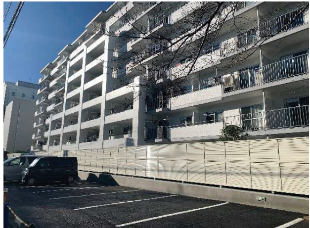
アウトフレーム補強事例
