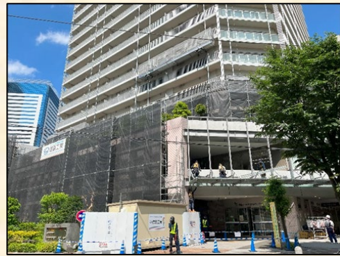
【A 工区作業風景】
