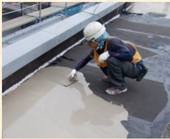
勾配レベラー下地調整
