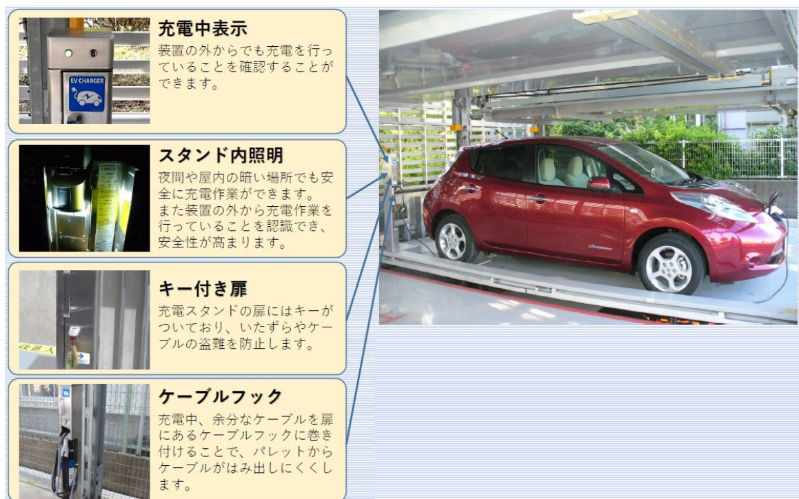
図 6-1. 機械式駐車場への充電設備設置例
